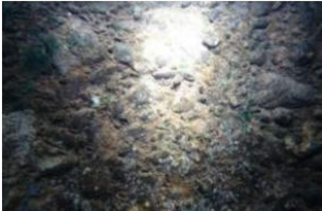
8#墩墩身及基础冲刷砂浆脱落
