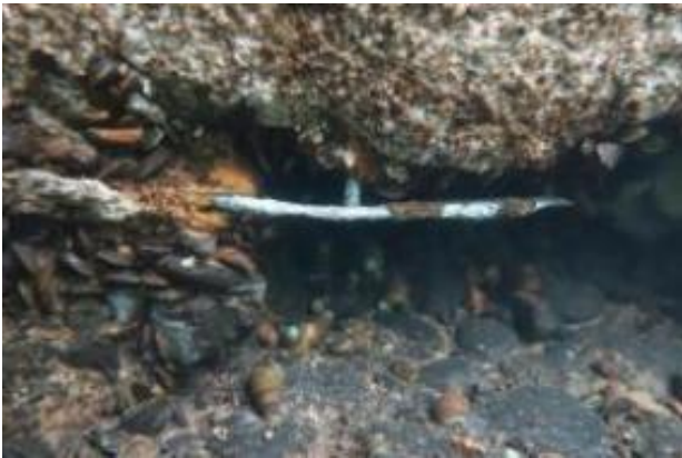
5#墩墩身及基础冲刷砂浆脱落
