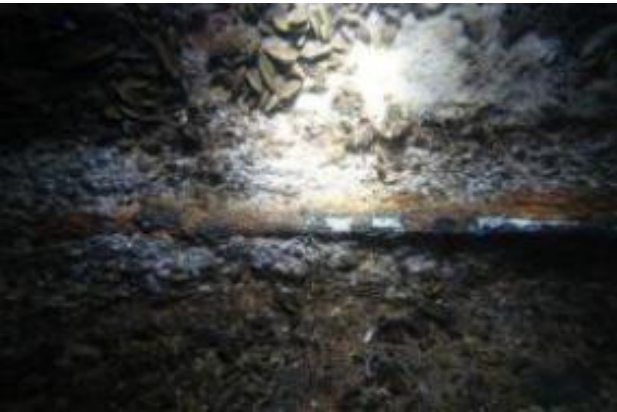
5#墩基础顶面露筋
